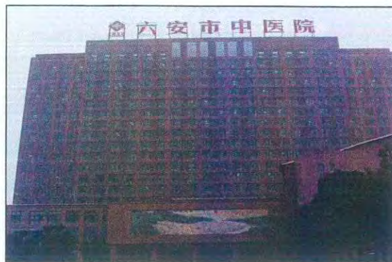
保留建筑病房大楼
