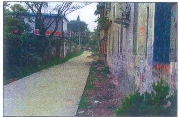
公园路待拆建筑
